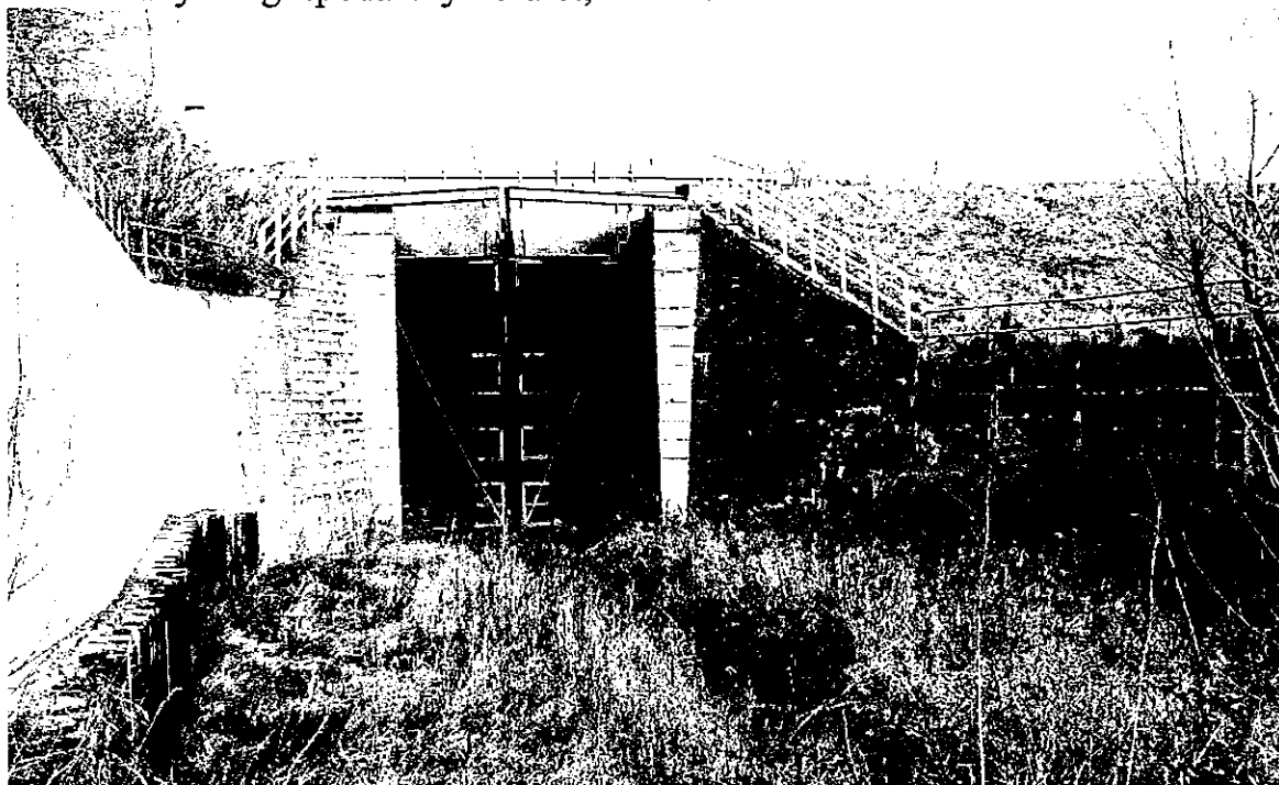
Ilustracja 32: Olza - przepust wałowy z drewnianymi wrotami.
