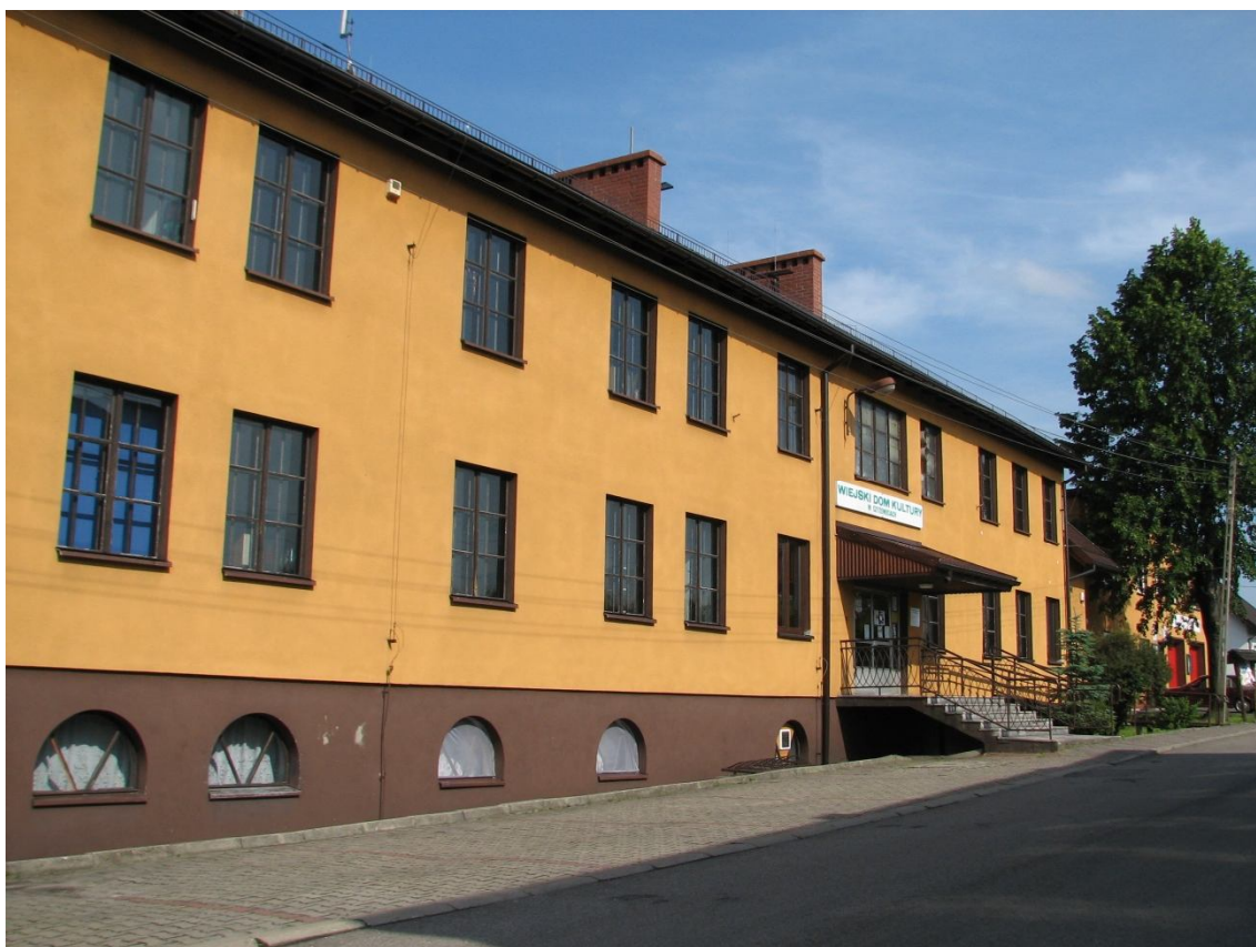
Elewacja frontowa - wschodnia Główne wejście do WDK
