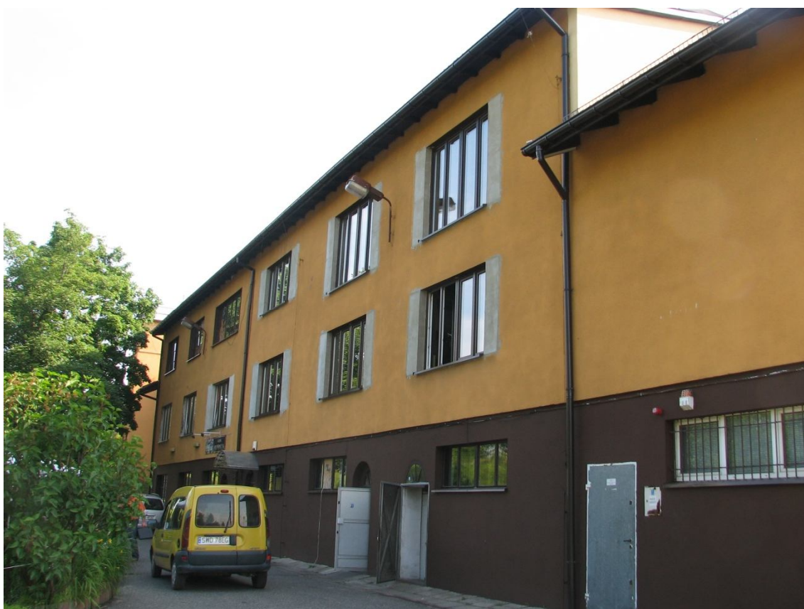
Elewacja tylna - zachodnia
