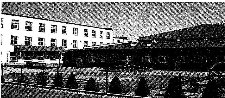
Zdjęcie nr 8. Budynek Zespołu Szkolno-Przedszkolnego w Gorzyczkach Źródło - opracowanie własne
