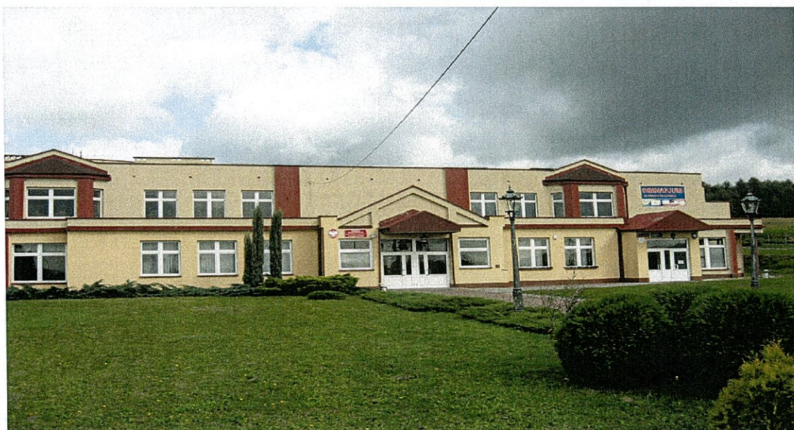
Zdjęcie nr 12. Budynek Szkoły Podstawowej i Gimnazjum w Turzy Śląskiej.
