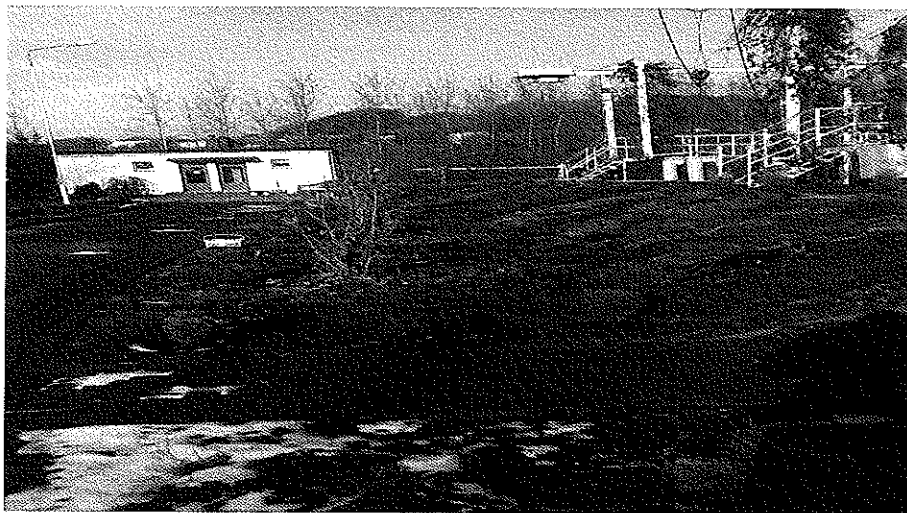
Zdjęcie nr 7. Oczyszczalnia ścieków w Belsznicy
