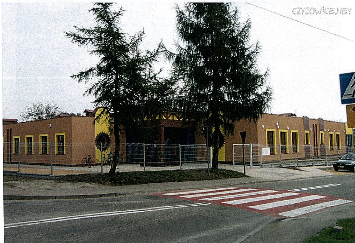
Zdjęcie nr 9. Budynek Przedszkola
