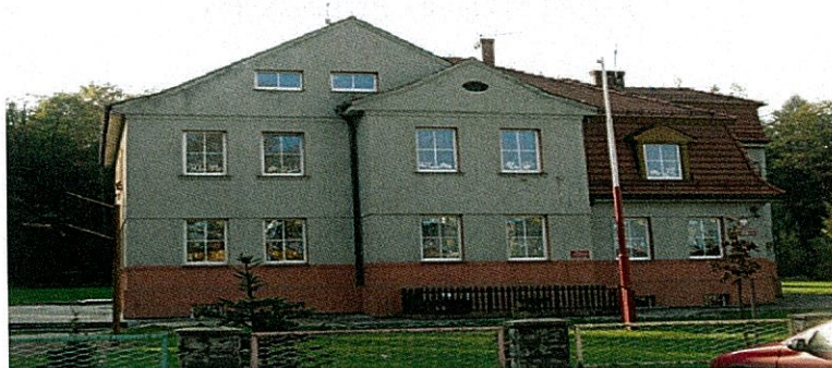
Zdjęcie nr 9. Budynek Szkoły Podstawowej nr 2 w Gorzyczkach przy ul. Leśnej w Gorzyczkach. Źródło - opracowanie własne
