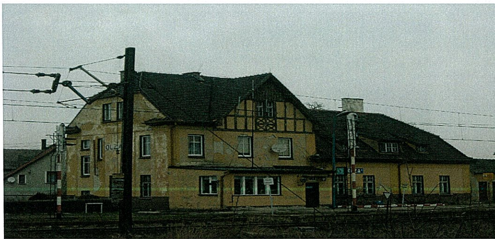
Zdjęcie nr 4. zabytkowy budynek dworca PKP w Olzie
