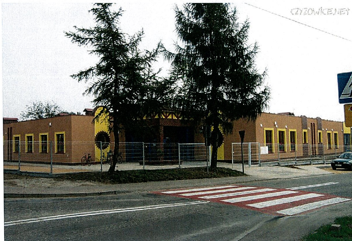
Zdjęcie nr 9. Budynek Przedszkola
