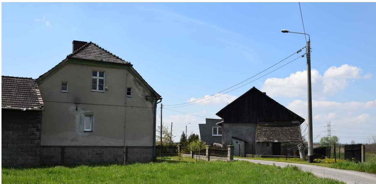
Ilustracja 43: Zdjęcie – widok z ulicy Wałowej w Belsznicy w 1 planie obiekt z lat 30stych XX wieku, w drugim planie obiekt mieszkalno-gospodarczy z końca XIX wieku, za nim wystaje budynek z lat 70-tych.
