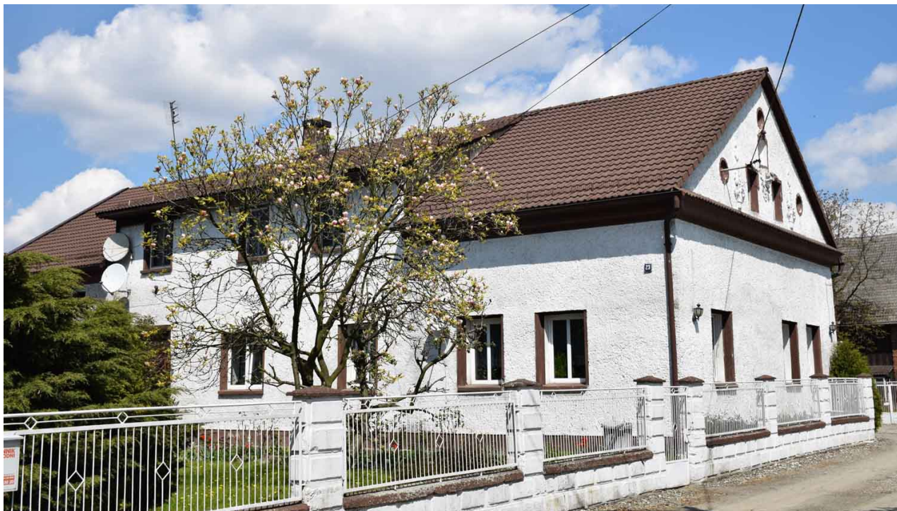
Ilustracja 8: Zdjęcie – Odra ulica Główna 23 – murowany budynek mieszkalny z 1842 roku.
