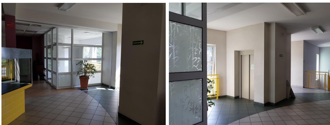
Nowa lokalizacja pomieszczenia administracyjnego jako zabudowa wolnej przestrzeni pomiędzy pom. użytkowym a szybem windy. Konieczność przełożenia drzwi windy na drugą stronę, podobnie jak to zrobiono na parterze (wtedy drzwi na obydwu kondygnacjach będą otwierać się w tą samą stronę). Lokalizację i wymiary otworu drzwiowego w szybie ustalić z producentem windy i realizować pod jego nadzorem.
