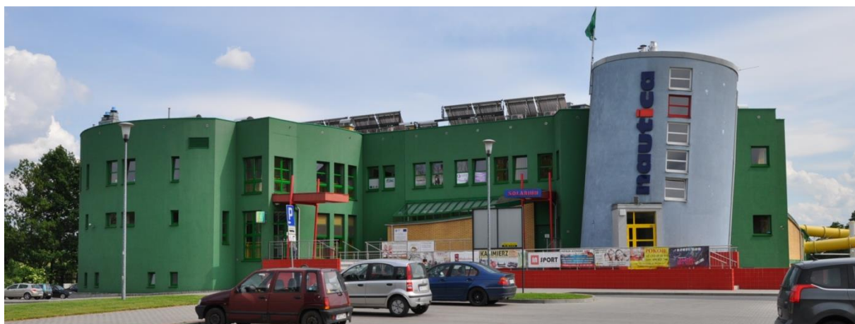
Kryta pływalnia „Nautica” w Gorzycach, foto: K. Fross, czerwiec 2015.
