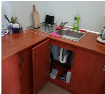
Foto. Istniejący pion wody i kanalizacji w narożniku pomieszczenia.
