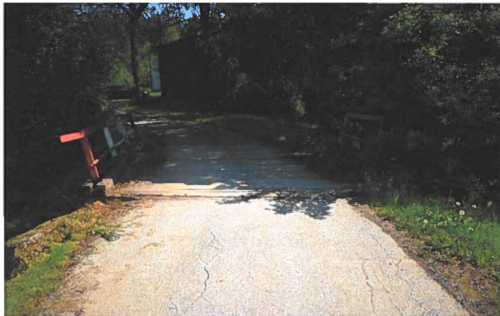
Fot. 1. Widok ogólny mostu z poziomu jezdni
