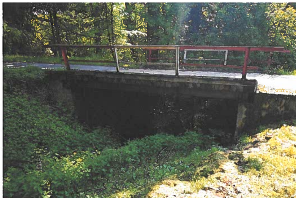
Fot. 2. Widok ogólny mostu z boku od strony wody górnej
