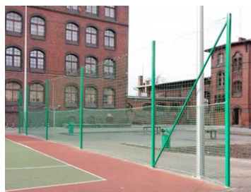
Fot. 5. Standardowa siatka ochronna bezwęzłowa, z polipropylenu o wysokiej wytrzymałości, średnica linki 5 mm, rozmiar oczka 8,0 x 8,0 cm.
