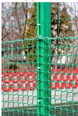
Fot. 1. Zdjęcie przykładowe montażu siatki do słupa piłkochwyty.
