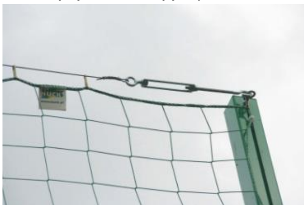
Fot. 1. Zdjęcie przykładowe montażu siatki do słupa piłkochwyty.
