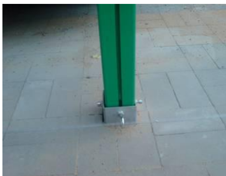
Fot. 1. Zdjęcie przykładowe montażu siatki do słupa piłkochwyty.
