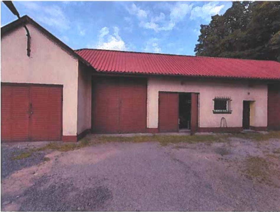
Fot. 2. Widok budynku .
