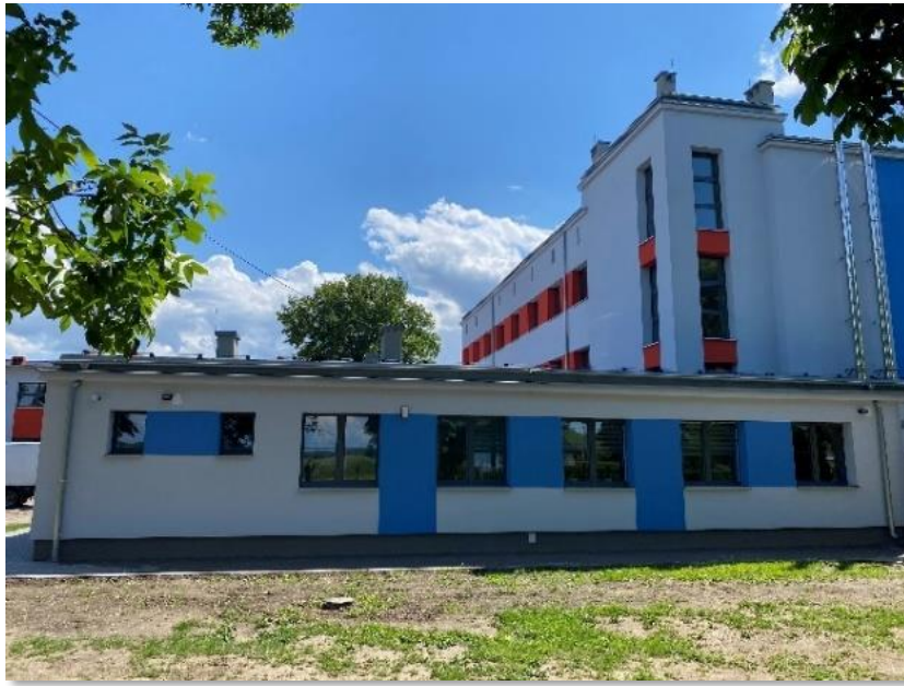
Zdjęcie 13. Budynek Zespołu Szkolno-Przedszkolnego w Olzie
